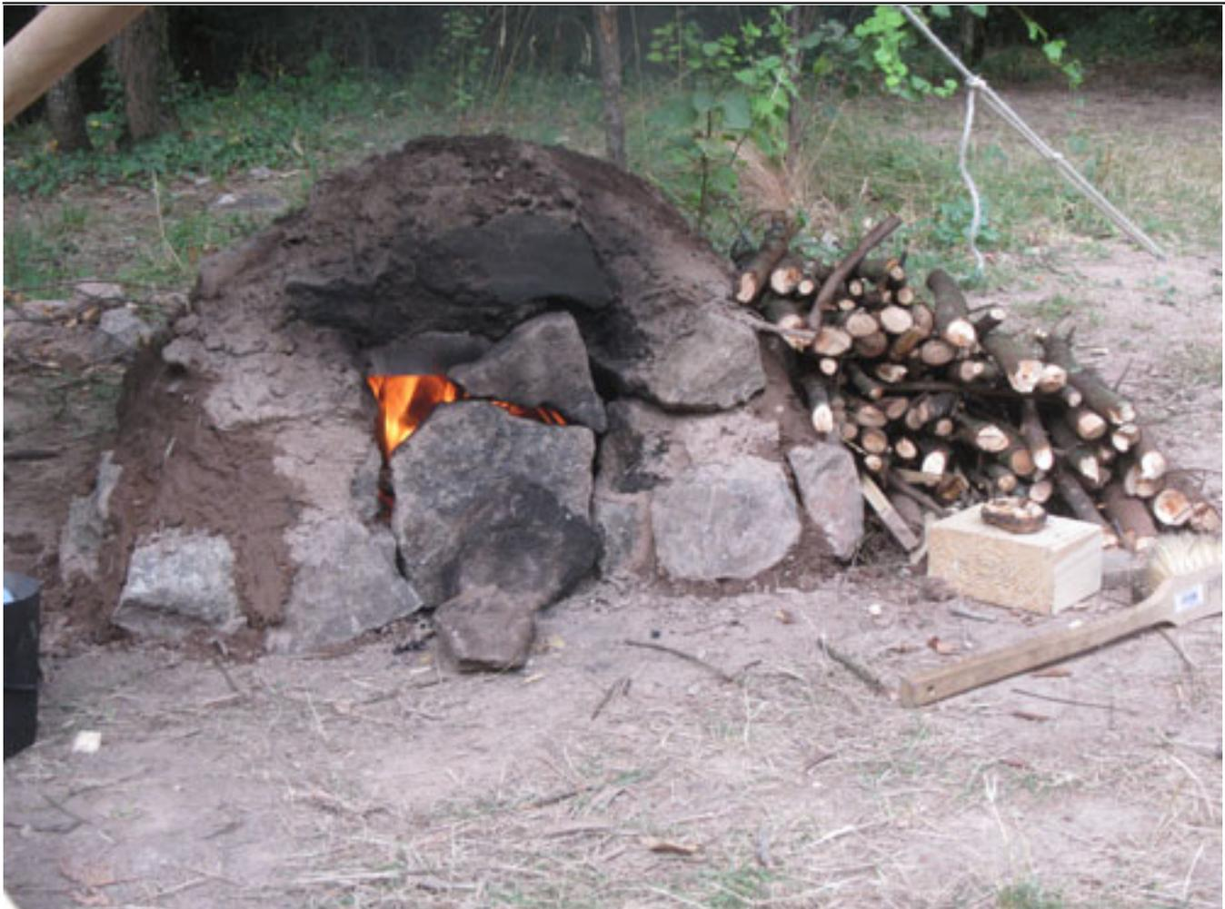
Unser Ofen war nur für ein Wochenende ausgelegt, aber mit ca. 50 cm Durchmesser und 30 cm Höhe schon sehr brauchbar zum Backen von verschiedenen Kleinigkeiten. Die Konstruktion ist aus Bruchsteinen, die mit einer Pampe aus sandiger Erde zusammengepappt wurden. Damit die Kuppel nicht so schwierig zu mauern ist, haben wir oben eine Grillschale aufgelegt und diese mit Steinen und Matsch abgedeckt.
