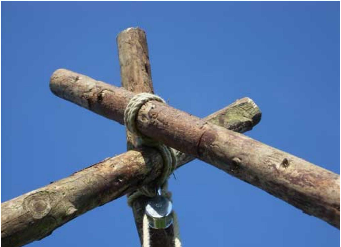
Oft werden Jurten mit einem Dreibein aufgestellt. Dazu werden drei Stangen an der Spitze verbunden und daran das Jurtendach in die Höhe gezogen. Um diese Stangen sicher zu verbinden eignet sich der Dreibeinbund am besten. Die Stangen halten sicher, ohne zu verrutschen und lassen sich dennoch flexibel bewegen.
