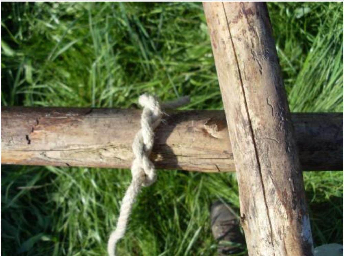
Bei Hölzern mit einem Durchmesser von 5 bis 7 cm nimmst du ein Seil mit drei Meter Länge und 8 mm Stärke. Sind die Balken dicker, sollte das Seil länger sein.
